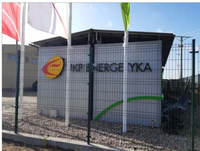
Magazyn energii na stacji Garbce
