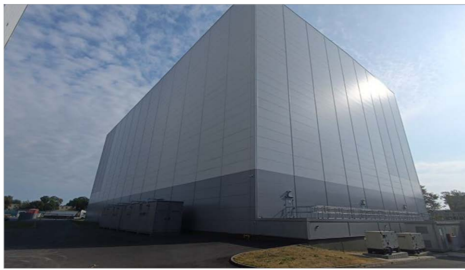
Rys. 1. Magazyn wysokiego składowania (w całości zautomatyzowany) bez stałej obsługi, w którym zainstalowano urządzenia inertyzujące. Źródło: Pfeifer & Langen Polska S.A.
