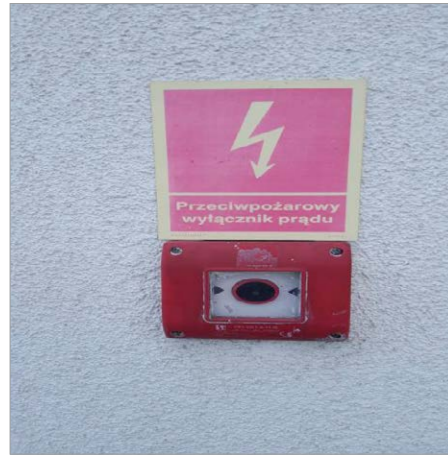
Rys. 2. Przycisk uruchamiający zdalnie przeciwpowozarowy wylacznik pradu bez sygnalizacji stanu zadzialania aparatu źródło: oprac. własne
