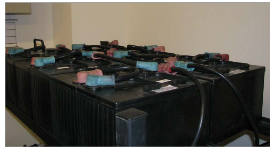
Fot. 1. Przykład układu połączeń zewnętrznych baterii akumulatorów na stojaku fot. JT
