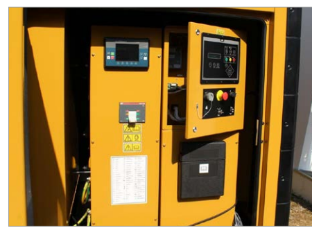
Fot. 1. Układ sterowania zespołu prądotwórczego zabudowanego w kontenerze fot. JT
