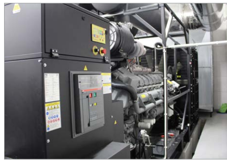
Układ sterowania zespołu prądowórczego o mocy 2,2 MVA fot. JT
