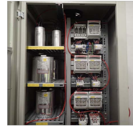
Rys. 3. System rozprzodzenia CO 2 w baterii kondensatorów rys. M. Żebrowski
