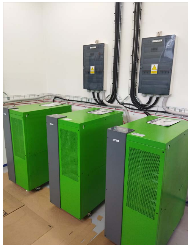
UPS EVER POWERLINE GREEN 33 PRO dzięki możliwości podwójnego przetwarzania energii (separacji energetycznej) pozwala na generowanie na wyjściu jednostki napięcia o najwyższej jakości parametrach VFI-SS-111. UPS EVER dzięki swoim funkcjonalnościom umożliwia także redukcję kosztów zasilania
