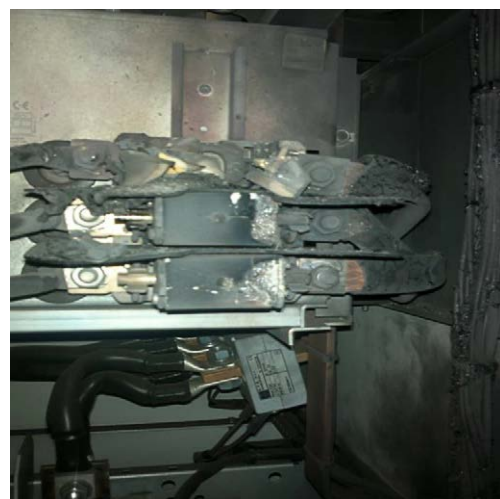
Rys. 8. Przykładowe uszkodzenia elementów zabezpieczających i przewodów zasilających rys. M. Żebrowski
