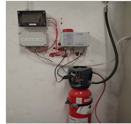
Rys. 2. System wypełniania wnętrza baterii CO 2 rys. M. Żebrowski
