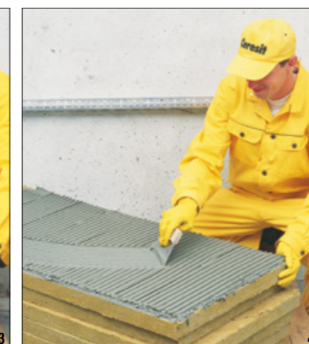
Fot. 1–5. Wybrane etapy prac przy montażu systemów ociepleń: 1 – kontrola stanu nośności podłoża, 2 – gruntowanie nasiąkliwe podłoża, 3–4 – nakładanie zaprawy klejowej na płytę dociepleniową (3 – metodą punktową, 4 – pacą ząbkowaną), 5 – przyklejanie płyt izolacyjnych
