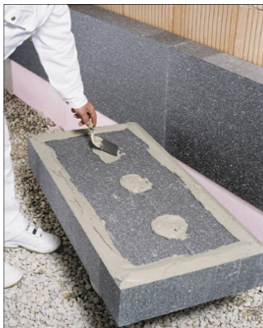
Klej nanosi się na płytę metodą punktowo-liniową
