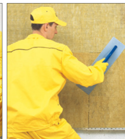
Fot. 1–5. Wybrane etapy prac przy montażu systemów ociepleń: 1 – kontrola stanu nośności podłoża, 2 – gruntowanie nasiąkliwe podłoża, 3–4 – nakładanie zaprawy klejowej na płytę dociepleniową (3 – metodą punktową, 4 – pacą ząbkowaną), 5 – przyklejanie płyt izolacyjnych
