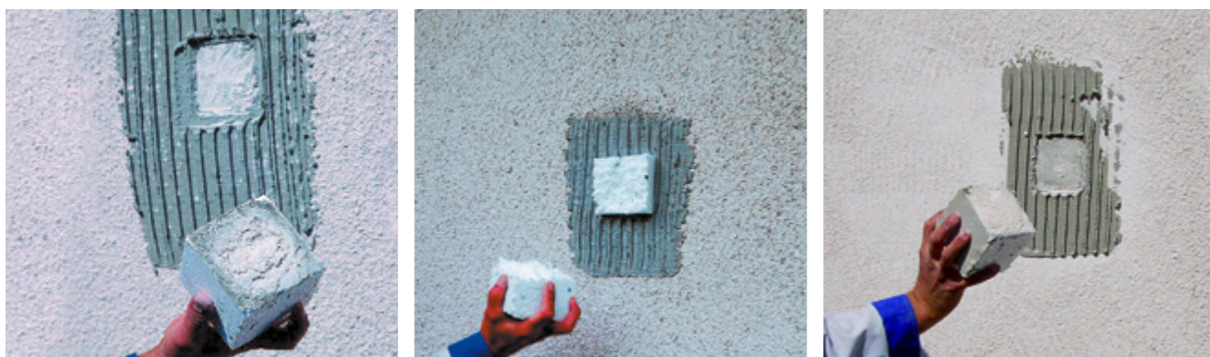
Próba przyczepności styropianu do podłoża
