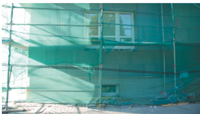
Styropian grafitowy bardziej pochłania promieniowanie słoneczne i szybciej się nagrzewa, przez co prowadzenie prac ociepleniowych z jego użyciem, szczególnie w okresie letnim, wymaga szczególnego osłaniania płyt przed słońcem
