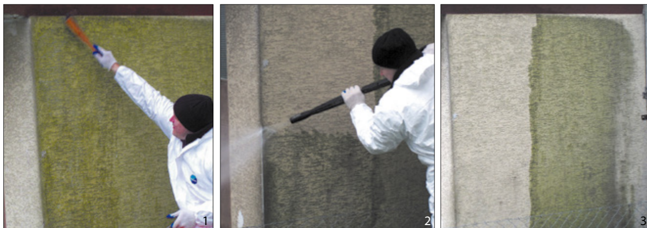
Czyszczenie mechaniczne ocieplonej elewacji zasiedlonej glonami: 1 – wstępne mycie elewacji i/lub nakładanie środka do sanityzacji; 2 – mycie elewacji pod ciśnieniem; 3 – efekt czyszczenia – po lewej stronie część ściany po zabiegach, po prawej – część nieoczyszczona Fot. archiwum SSO
