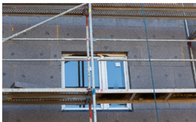
Styropian grafitowy ma podobne do białego właściwości mechaniczne, ale lepsze od białych płyt parametry w zakresie termoizolacyjności, co pozwala na montaż cieńszej warstwy izolacji
