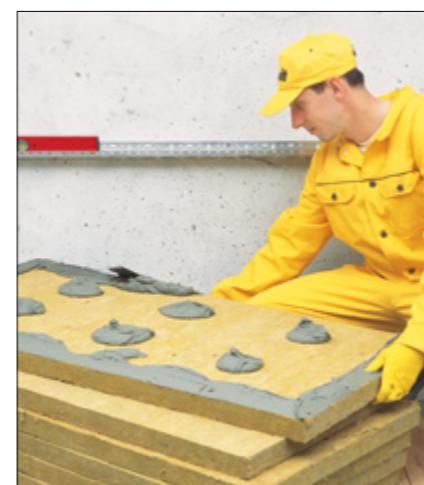
Fot. 1–5. Wybrane etapy prac przy montażu systemów ociepleń: 1 – kontrola stanu nośności podłoża, 2 – gruntowanie nasiąkliwe podłoża, 3–4 – nakładanie zaprawy klejowej na płytę dociepleniową (3 – metodą punktową, 4 – pacą ząbkowaną), 5 – przyklejanie płyt izolacyjnych
