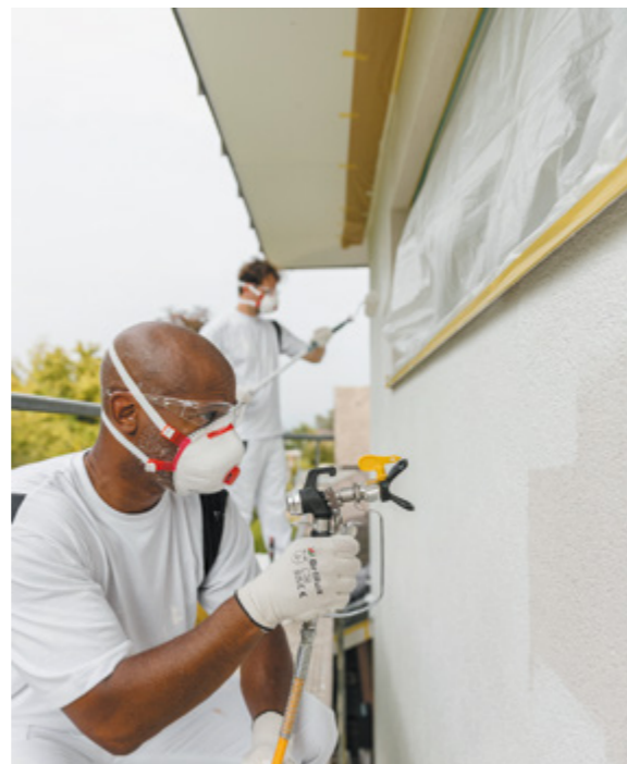
Elewacyjne farby silikonowe są odporne na zabrudzenia oraz porastanie glonami i grzybami. Można je aplikować pędzlem, wałkiem lub metodą natryskową Fot. Brillux
