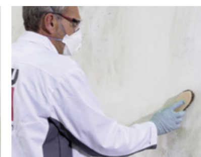
Czyszczenie elewacji Fot. Baumit
