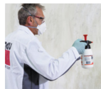
Nanoszenie środka czyszczącego Fot. Baumit
