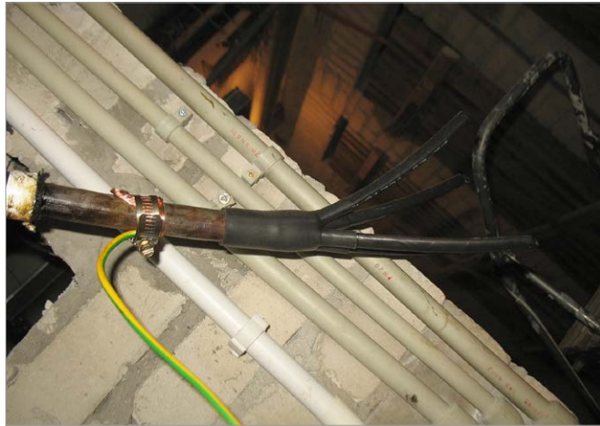
Fot. 1. Montaż mufy przejściowej na kablu o izolacji papierowo-olejowej fot. K. Kuczyński
