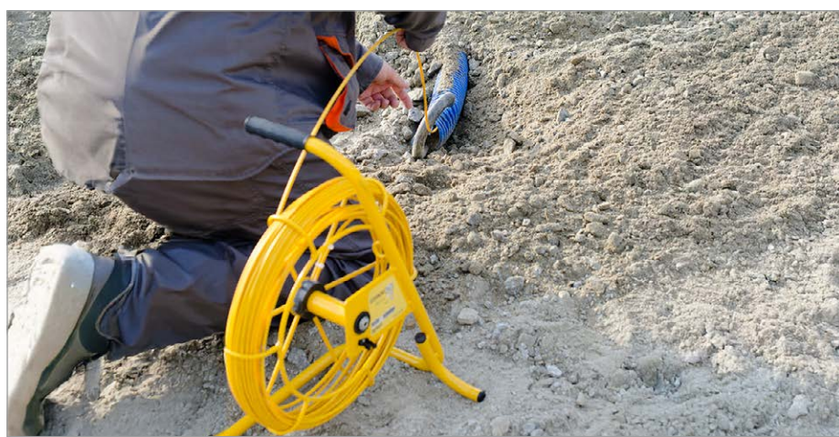
Fot. 5. Lokalizacja infrastruktury nieprzewodzącej przy użyciu specjalnego przewodu nadawczego
