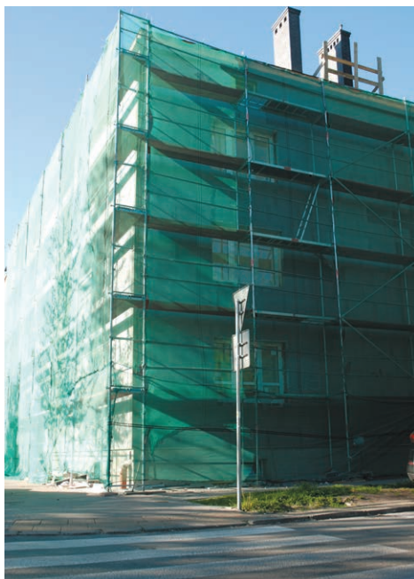
FOT. 1 Rusztowanie – siatki zacieniające; fot.: PSPS
