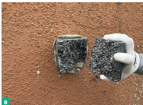
FOT. 5–8 Przykład weryfikacji nośności podłoża uproszczoną metodą odrywania kostki styropianu; fot.: autor
