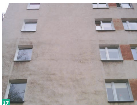
FOT. 14–17 Porównanie sprawności termicznej przegród zewnętrznych dwóch sąsiednich budynków położonych na południowym zachodzie Polski. Elewacje północne. Niebo zachmurzone, wiatr łagodny, ustabilizowana temperatura powietrza +6,8^{\circ}\text{C} . Pomiary średnich temperatur powierzchni wykonano jednego dnia przy tych samych warunkach atmosferycznych za pomocą kamery termowizyjnej. Różnica wartości średnich wyniosła aż 1,4\text{ K} . Ciepłsza przegroda o wyraźnie niedostatecznej izolacyjności termicznej ze wskazaniem do termomodernizacji; fot.: autor
