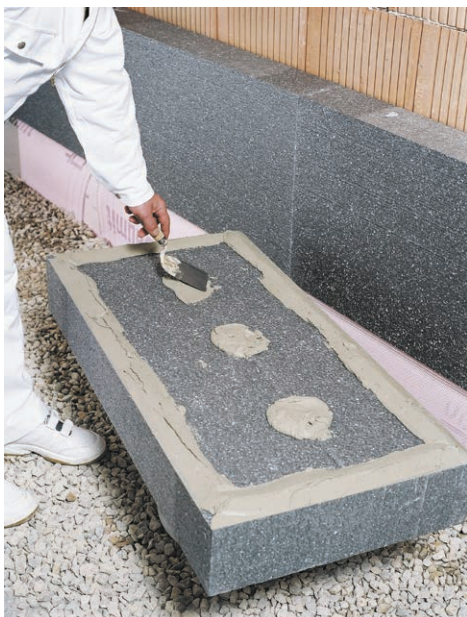
FOT. 3 Nakładanie kleju – metoda obwodowo-punktowa;
