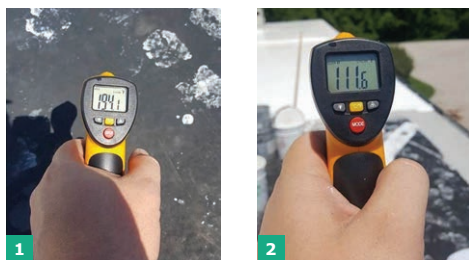
FOT. 1–2. Odczyt temperatury przed (194°F/90°C) oraz po (111°F/43°C) zastosowaniu jasnego pokrycia dachowego; fot.: www.buildingenclosureonline.com
