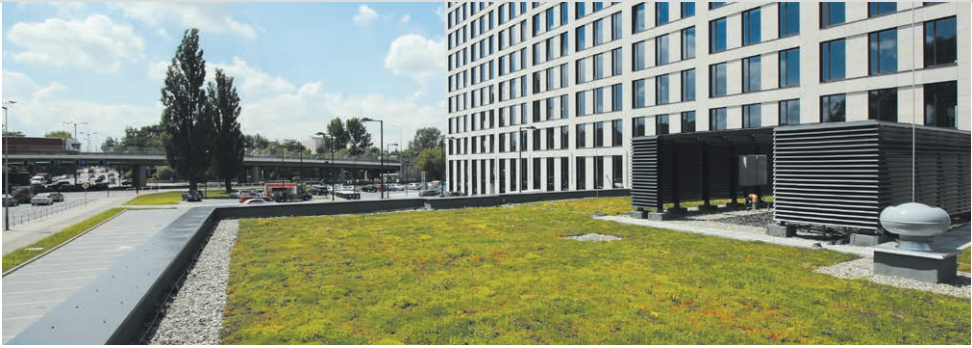
FOT. 3. Dach zielony w uprawie ekstensywnej. Rozchodniki to rośliny, które dobrze znoszą brak opadów i duże nasłonecznienie; fot.: Piotr Wolański APK Dachy Zielone
