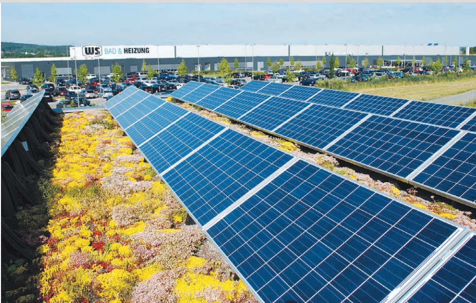
FOT. 1. Fotowoltaika na zielonym dachu z roślinnością w uprawie ekstensywnej; fot.: Optigrüen International AG
