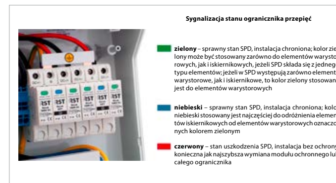
Rys. 5. Sygnalizacja stanu SPD
