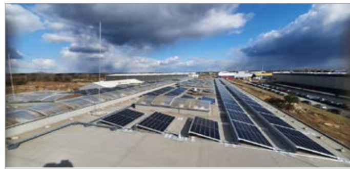
Nowatorskim rozwiązaniem wśród systemów samonośnych są konstrukcje montowane bezinwazyjnie – poprzez klejenie lub zgrzewanie Fot. energy5
