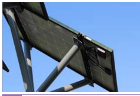
Fot. 6. Widoczne w świetle widzialnym odbicia na szklanych nierównościach spodniej strony panelu PV fot. K. Kuczyński, G. Dymny
