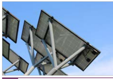
Fot. 10. Widoczne w świetle widzialnym odbicia na szklanych nierównościach spodniej strony panelu PV [7]
