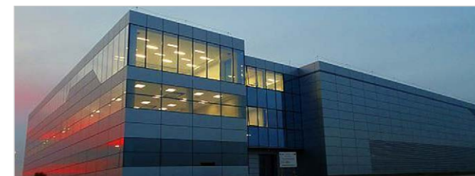
Fot. 1. Nowoczesne data center w Alwerni pod Krakowem zbudowane przez firmę Polcom [27]
