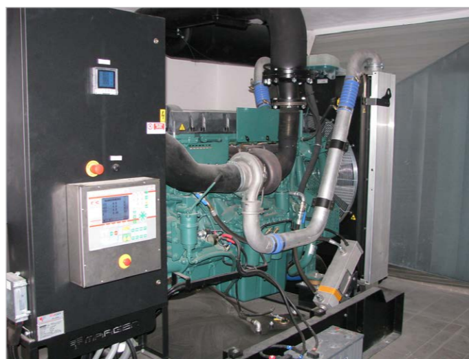
Fot. 1. Przykładowa instalacja zespołu prądowórczego w pomieszczeniu
