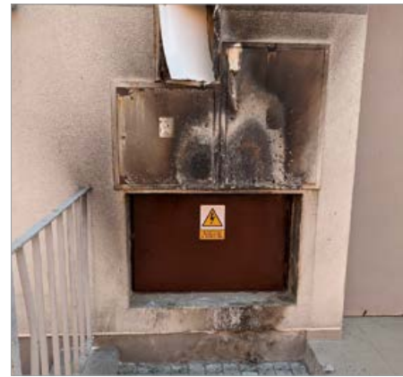
Fot. 1. Skutki pożaru złącza kablowego i rozdzielnic pomiarowo-dystrybucyjnych fot. K. Kuczyński
