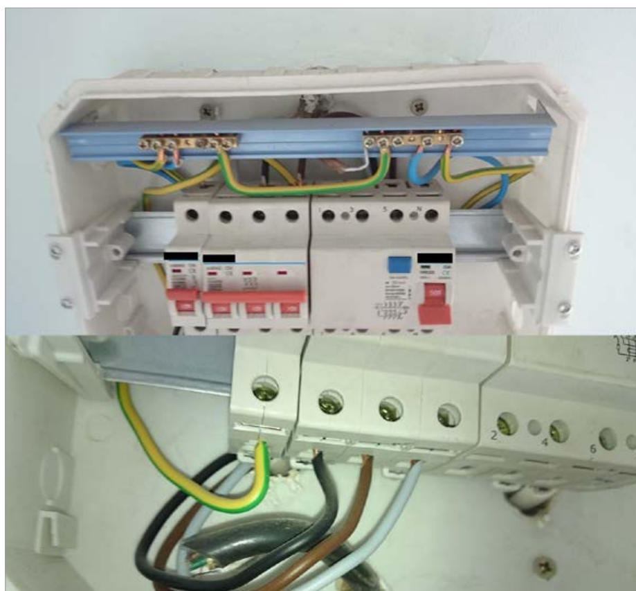
Fot. 1. Niepodłączony wyłącznik różnicowoprądowy fot. K. Kuczyński
