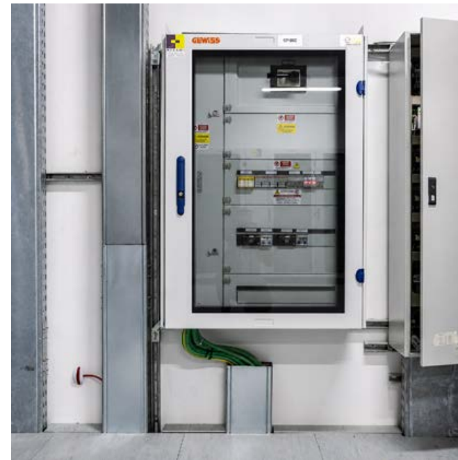
Fot. 3. Rozdzielnica CVX 160 E
