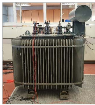
Rys. 8. Widok obiektu testowego nr 1
