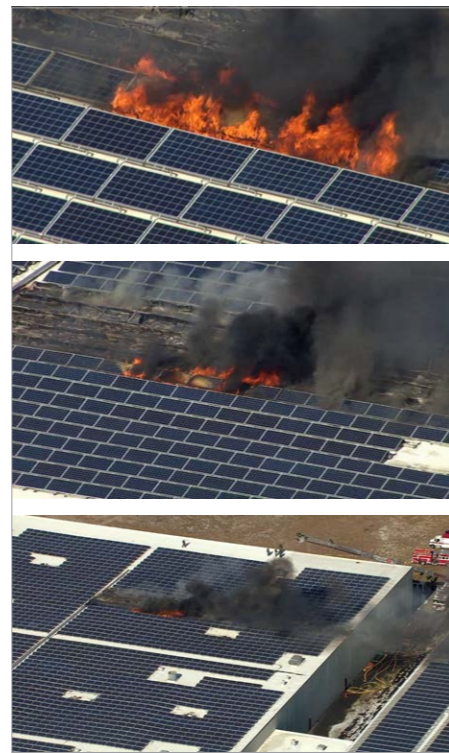
Fot. 2. Pożar hali produkcyjnej i akcja straży pożarnej [4]
