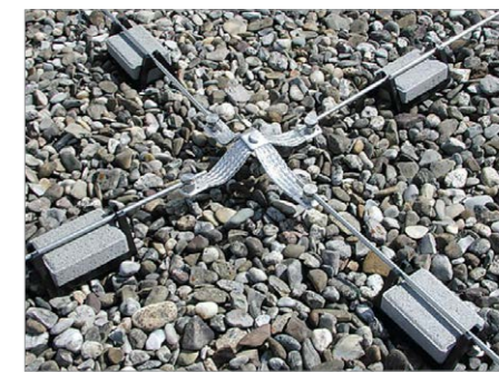
Rys. 8. Połączenia elastyczne za pomocą taśm stalowych lub aluminiowych między prętami zwodów poziomych w miejscu ich krzyżowania [4]
