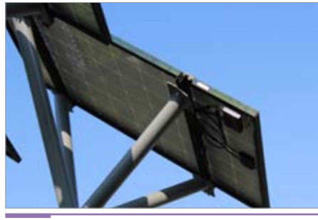
Fot. 6. Widoczne w świetle widzialnym odbicia na szklanych nierównościach spodniej strony panelu PV fot. K. Kuczyński, G. Dymny
