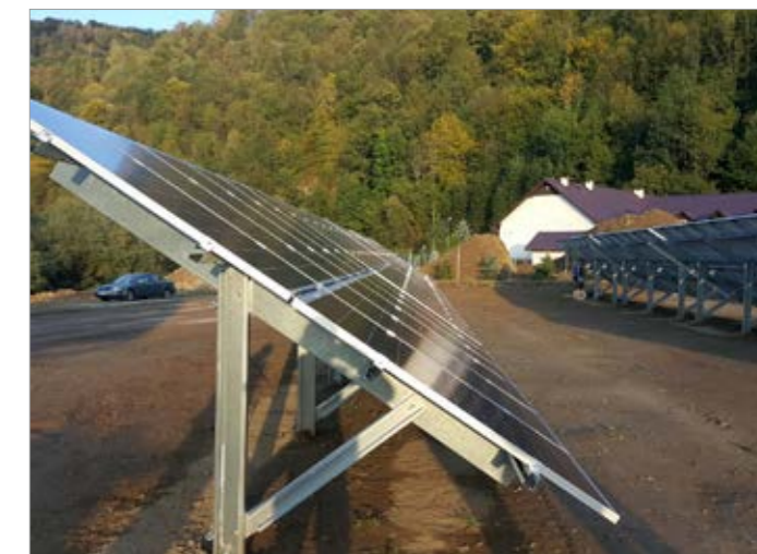
Przykład realizacji z wykorzystaniem instalacji wsporczych Fot. Solsum
