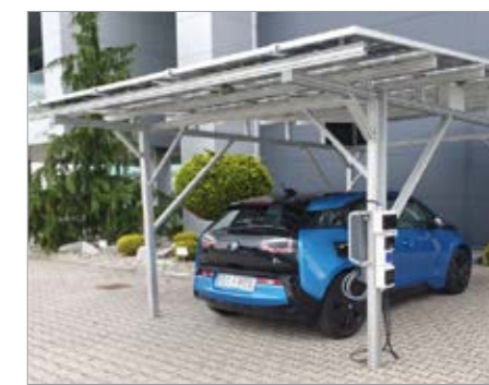
Rys. 3. Przykład wiaty garażowej z zainstalowaną stacją ładowania samochodów elektrycznych [8]
