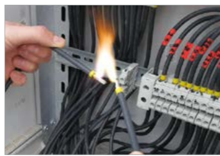
Fot. 1. Praca na zwarcie stringu paneli PV zainstalowanych na dachu obiektu fot. J. Wiater
