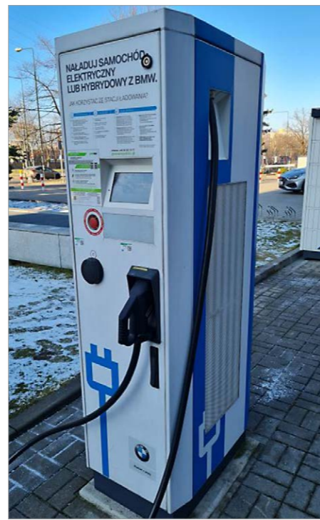
Fot. 1. Dwupunktowa stacja ładowania szybkiego firmy BMW Group znajdująca się w Warszawie na Mokotowie fot. K. Nita
