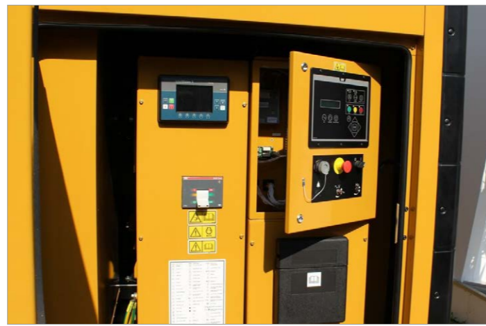
Fot. 1. Układ sterowania zespołu prądotwórczego zabudowanego w kontenerze fot. JT
