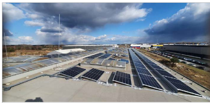
Najnowszym rozwiązaniem wśród systemów samonośnych są konstrukcje montowane bezinwazyjnie – poprzez klejenie lub zgrzewanie Fot. energy5
